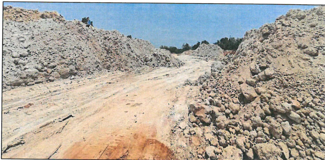
照片4 II号堆场照片
