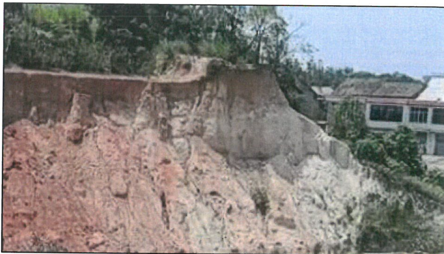
照片2 建设工程揭露汨罗组 (Qpm) 高岭土矿体断面
